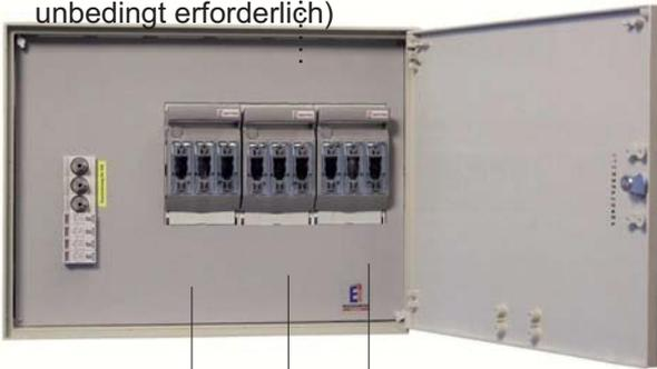
Je ein Trenner für WMF, Zählergerüst und z.B. Gewerbeanlage
